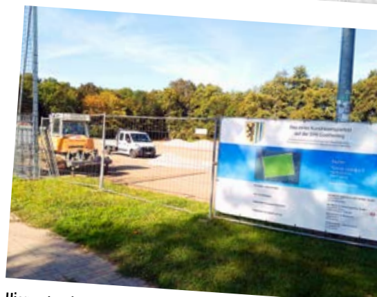
Hier entsteht der neue Kunstrasen-Platz für die Fußballer
